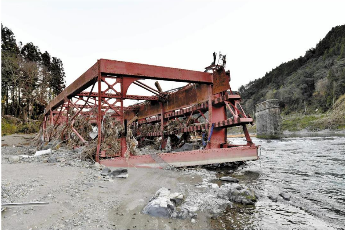
橋桁ごと流され、球磨川に横たわる第2球磨川橋りょう。右奥に見えるのが橋脚（昨年12月、熊本県球磨村で）＝内村大作撮影
