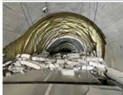
国道249号大谷トンネル（珠洲市）
