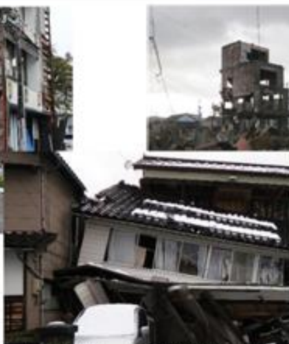
木造建築物の倒壊状況（穴水町）
