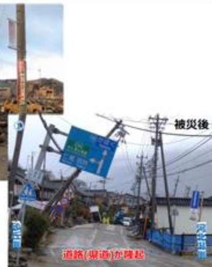
液状化による地盤の流動状況（内灘町）
