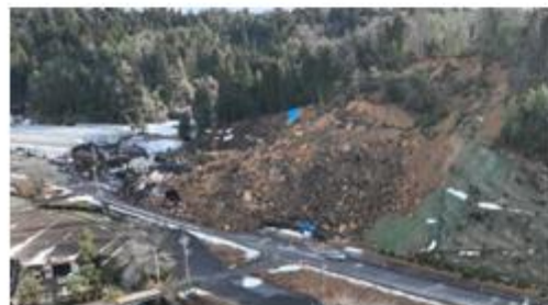
山腹崩壊（珠州市正院町地内）
