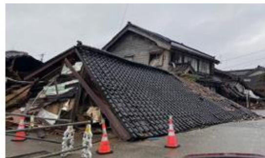
家屋倒壊（珠州市三崎町地内）
