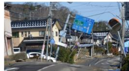
液状化（内灘町西荒屋地内）
