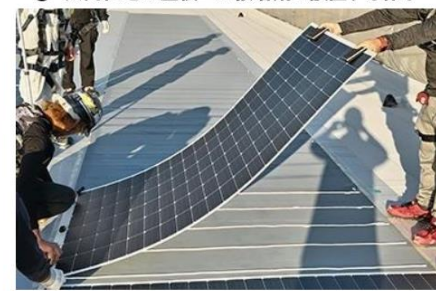
④ 曲面のある屋根上に設置
