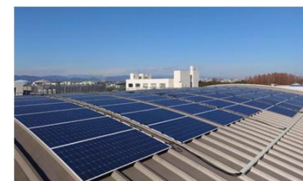
④ 曲面のある屋根上に設置
