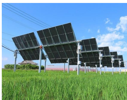
太陽光追尾型架台および両面モジュールでの 次世代営農型太陽光発電の実証事業
